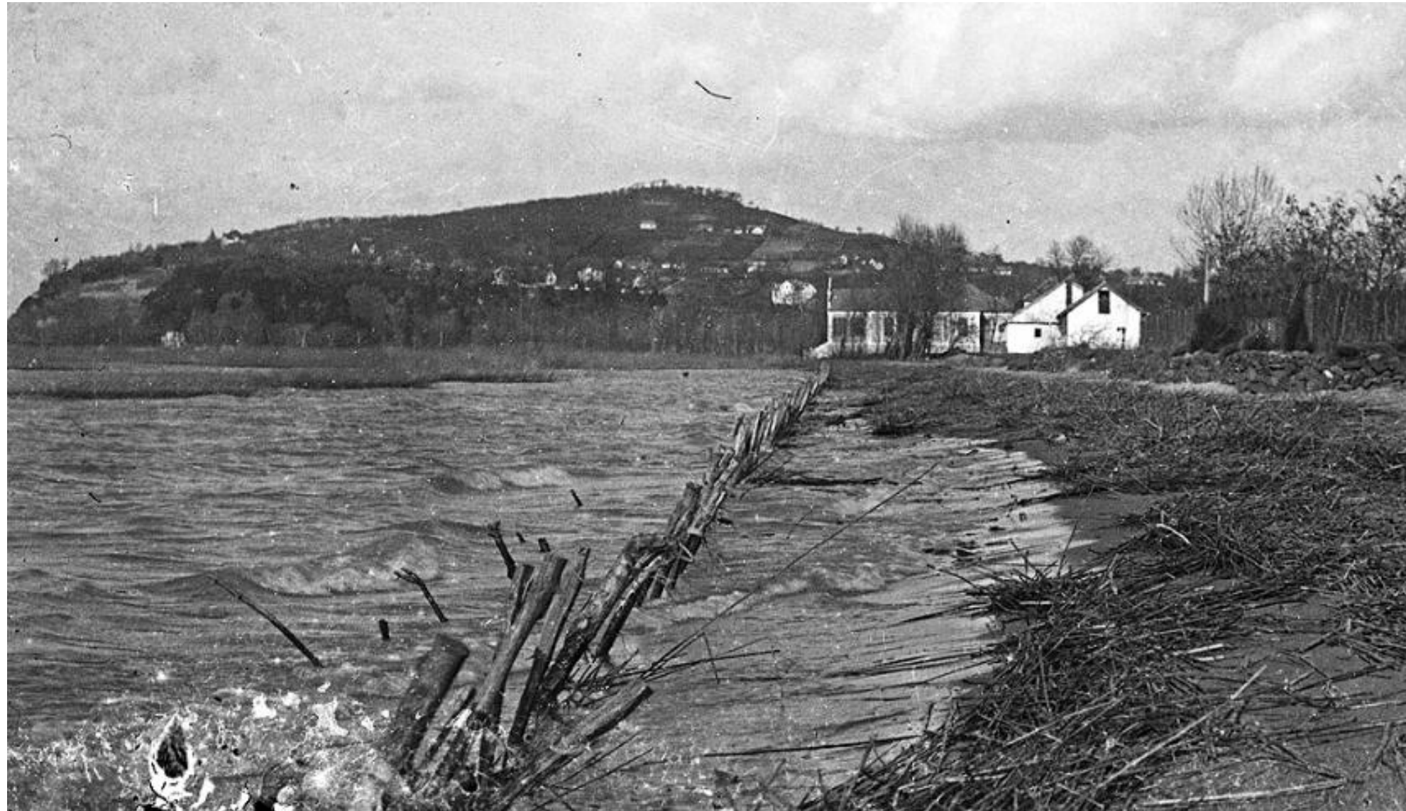
Fonyód-Bélatelep, 1914 Kezdetleges partvédelem cölöpökkel
