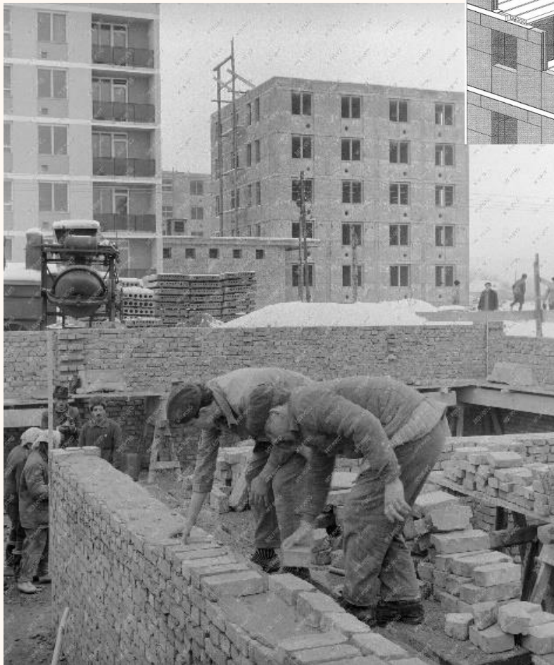
Blokkos falszerkezetű társasház alapozási munkái a Kilián Délen 1963. december 29.-én. Forrás: MTI Nemzeti Archívum.
