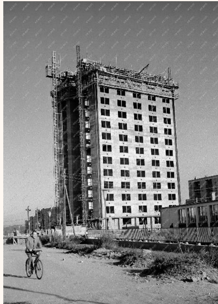
A Kilián Déli lakótelepen, csúszózsalus technológiával épített 15 szintes lakóépület 1965. október 12.-én. Forrás: MTI Nemzeti Archívum.
