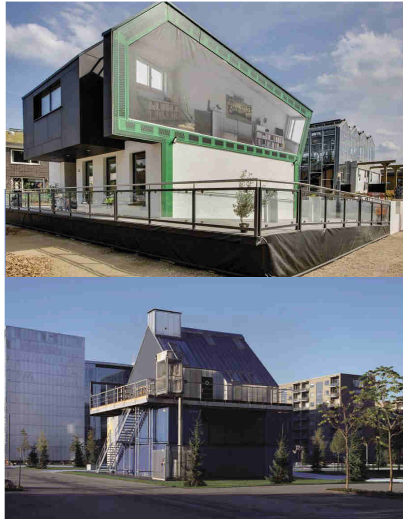
Több emeletes lakóház / tetőtér-beépítés
